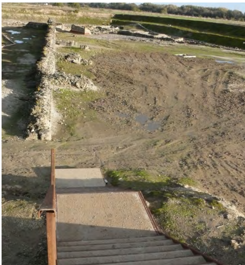
Fig. 2: Vista dell'area orientale di Casa Bianca dalla scala d'accesso, in cui si notano le zone depresse soggette al ristagno dell'acqua.
