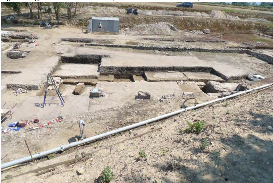
Fig. 5: L'area dell'edificio N (v. Foto 2 relazione generale) alla fine dello scavo del 2011
