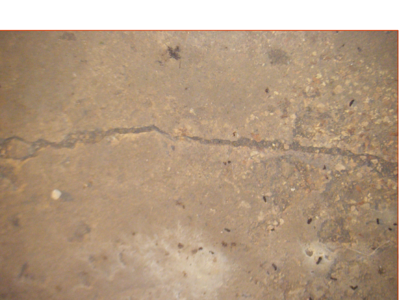
Foto particolare del pavimento in coccio pesto
