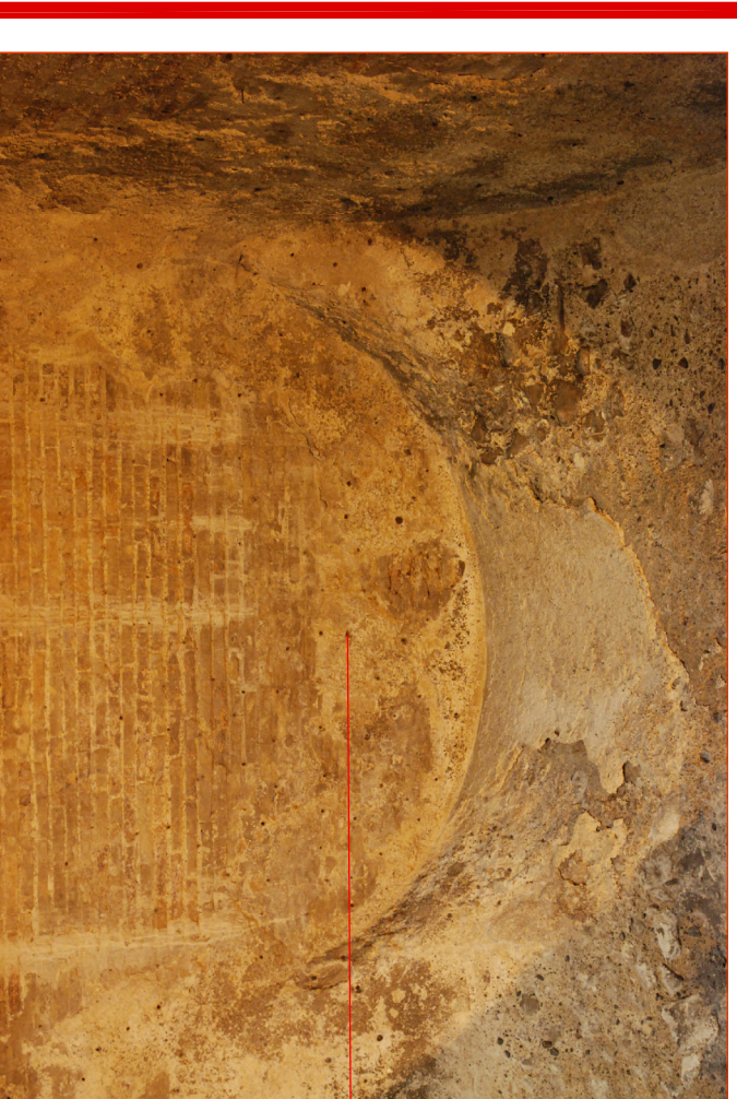
Foto con il particolare delle chiodature
