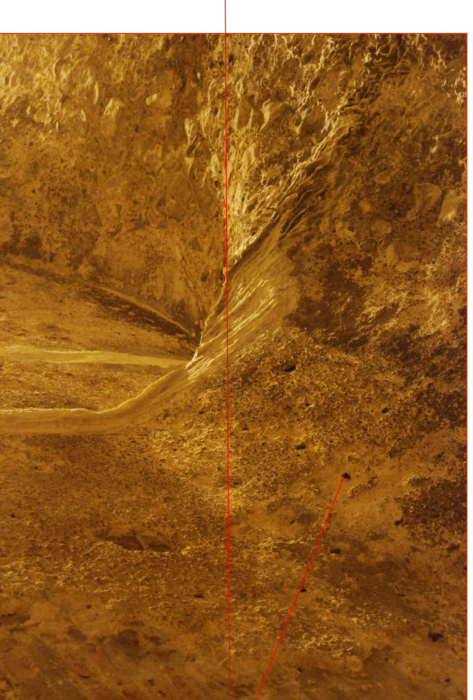
Foto con il particolare delle chiodature
